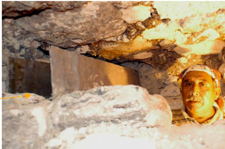
**Foto 18.** Vemos el canal de fibra de vidrio uniendo los dos lados del túnel, listo para ser rellenado con piedras y mezcla.
