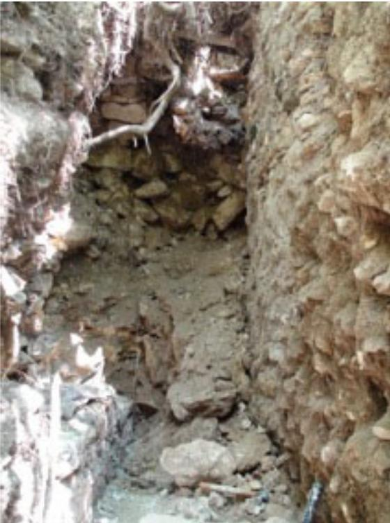
**Foto 1.2 Colapso bloqueando la entrada del túnel oeste en marzo de 2014.
